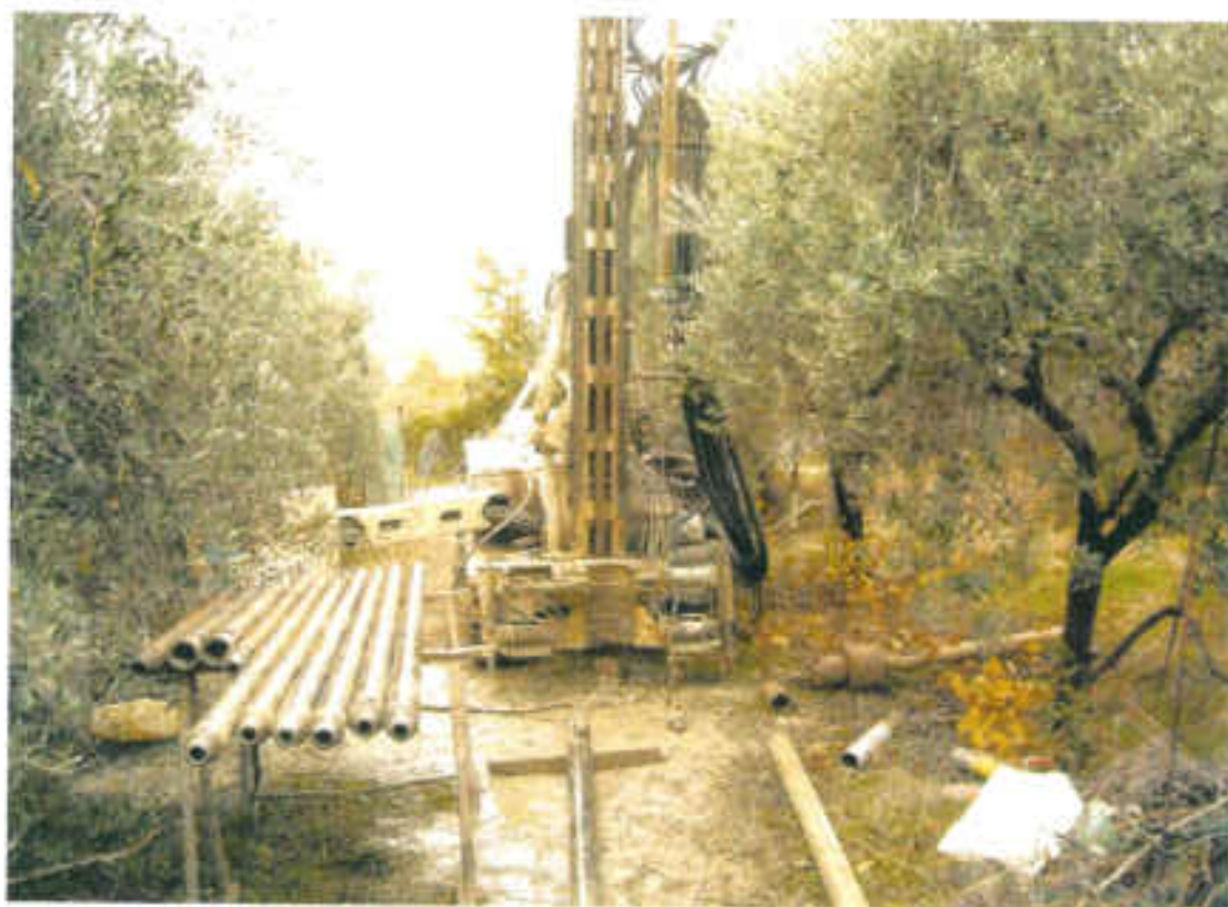
Foto posazione sondaggio
