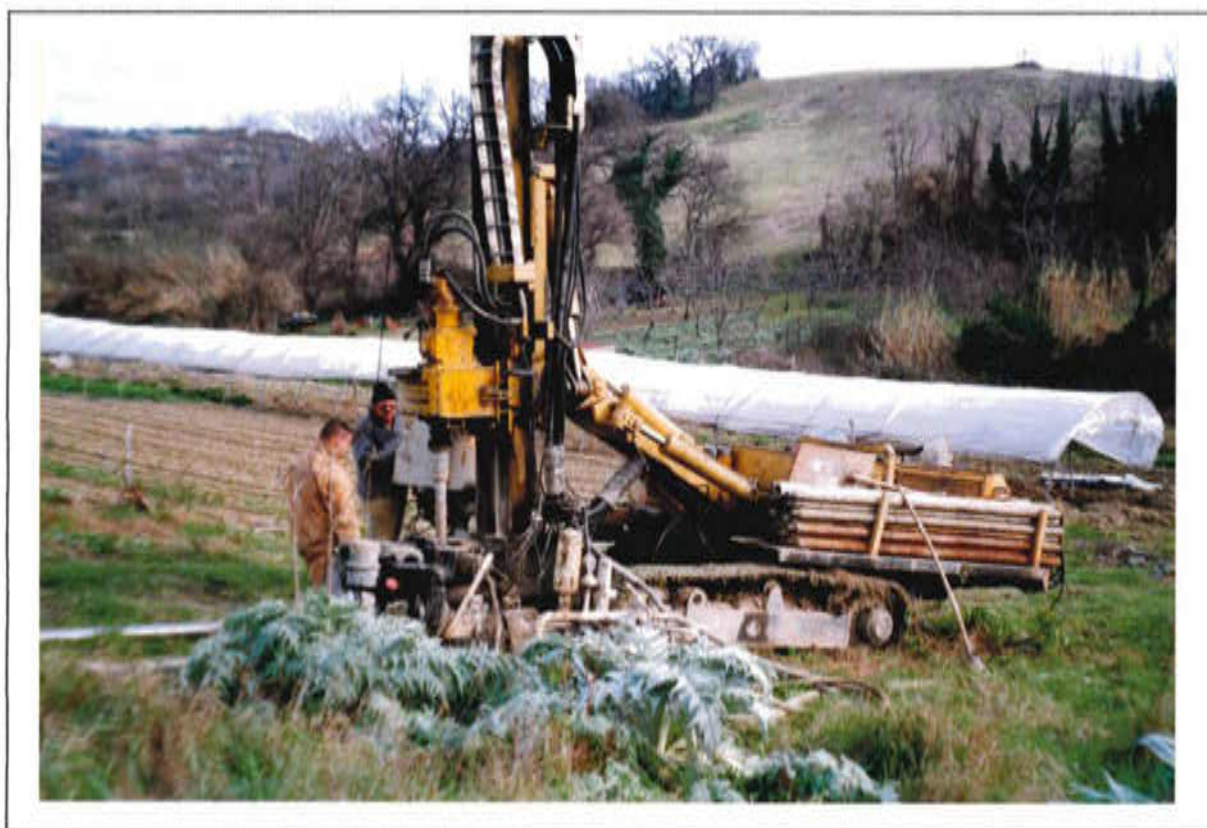
Postazione Sondaggio S3P Cantiere: Montemarino -Ancona
