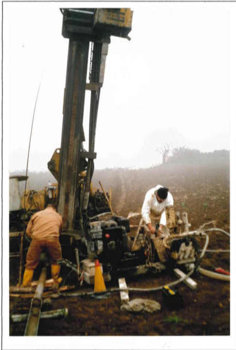
Postazione Sondaggio S1P Cantiere: Montemarino -Ancona
