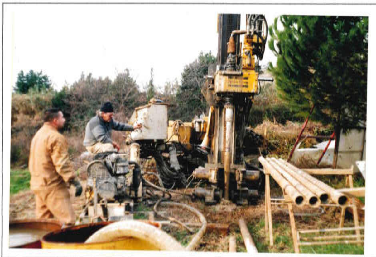
Postazione Sondaggio S2P Cantiere: Montemarino -Ancona
