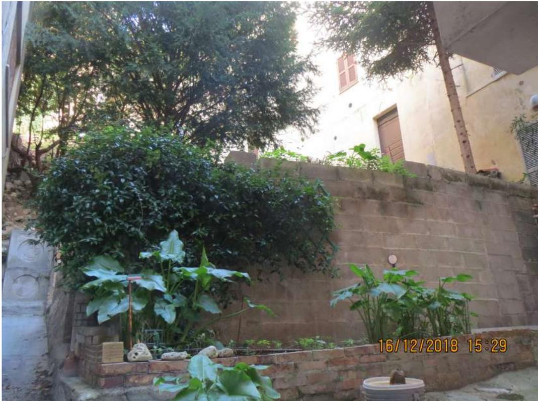
*Foto n. 7 - Muro di sostegno dell'attuale terrazzamento a quota +3,20*
