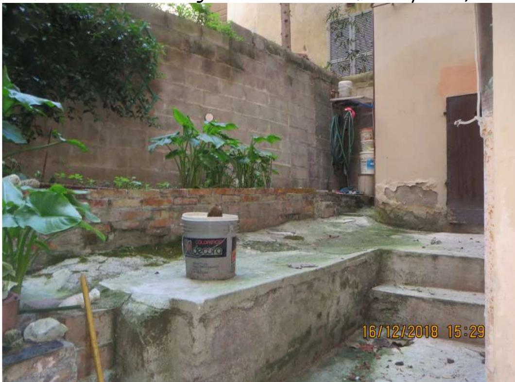
*Foto n. 8 - Muro di sostegno dell'attuale terrazzamento a quota +1,45*
