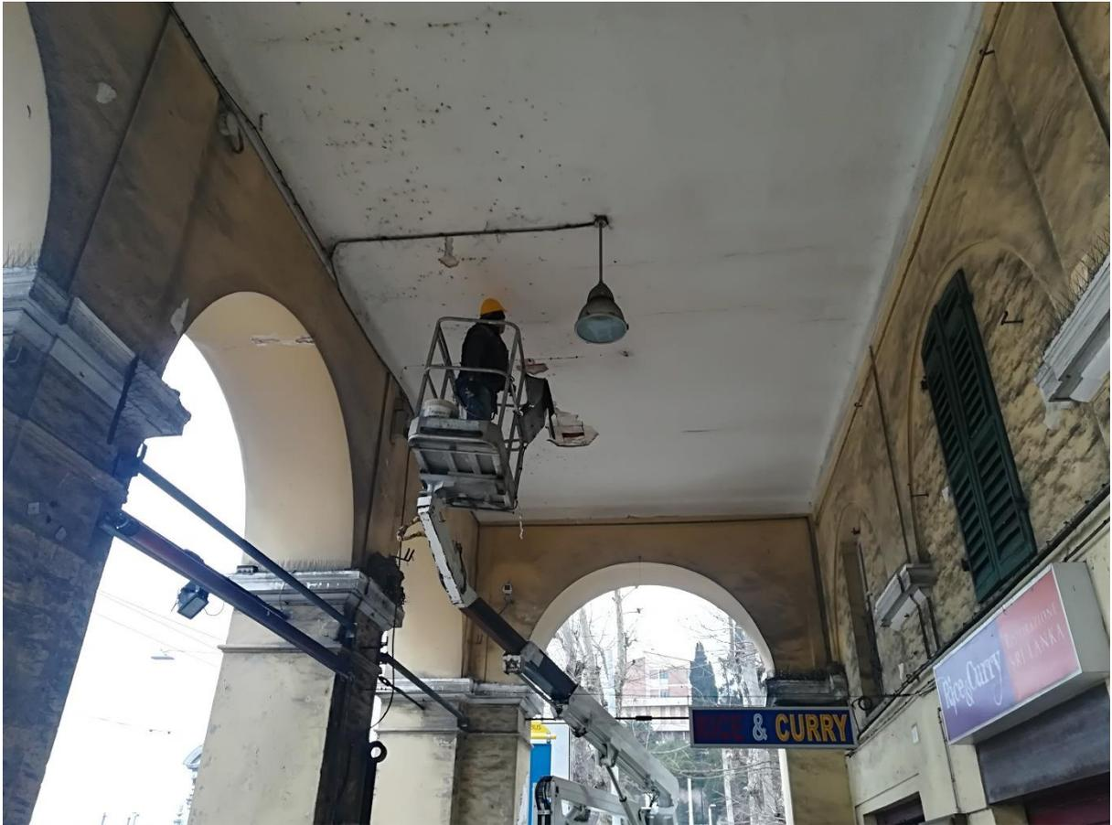
Esecuzione saggi soffitto Isolato 5 con piattaforma elevatrice
