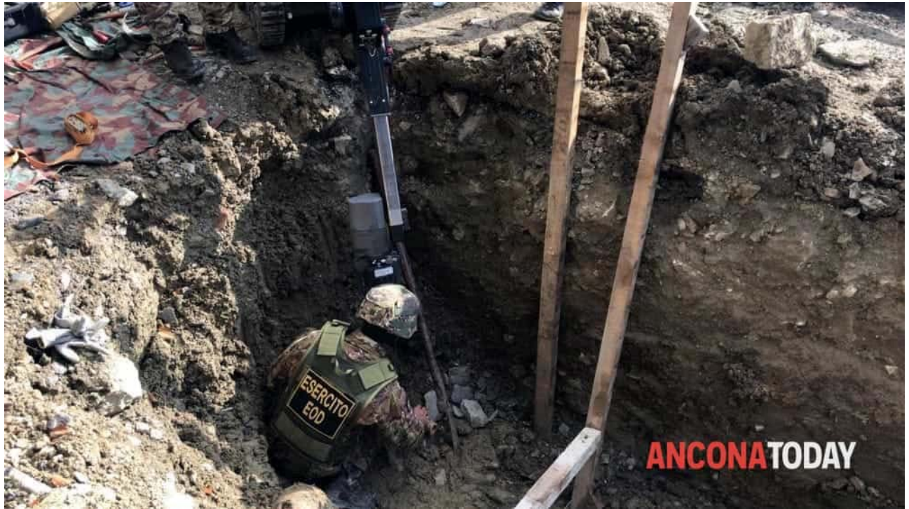
20 gennaio 2019 - intervento di bonifica
