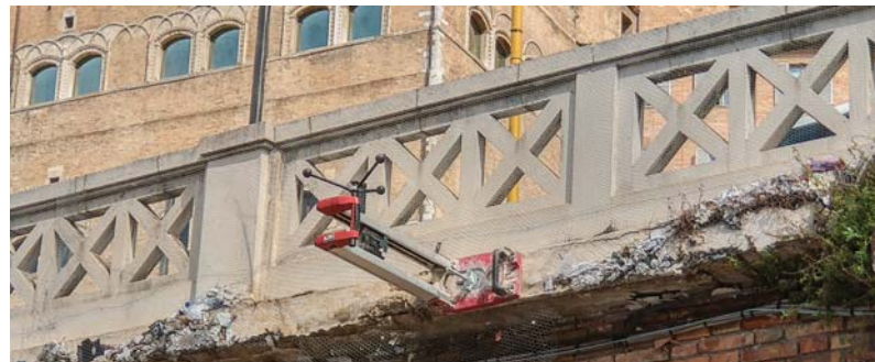
Foto n. 4 Prelievo di provino cilindrico di calcestruzzo "C2" da soletta del marciapiede (lato Fincantieri)
