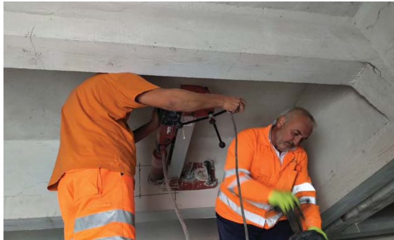
Foto n. 15 Prelievo di provino cilindrico di calcestruzzo “C5” da trave interna (locale Banchina da Chio 5)
