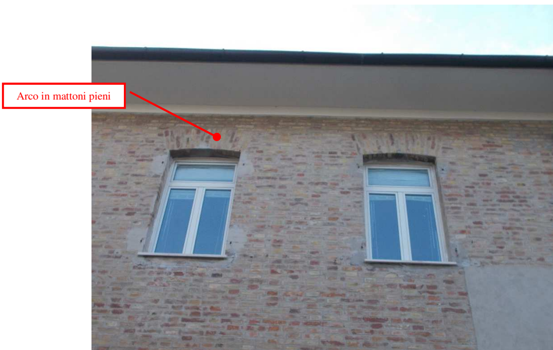
FOTO 12 – Piano Primo. Architrave esterno realizzato con un arco di mattoni pieni
