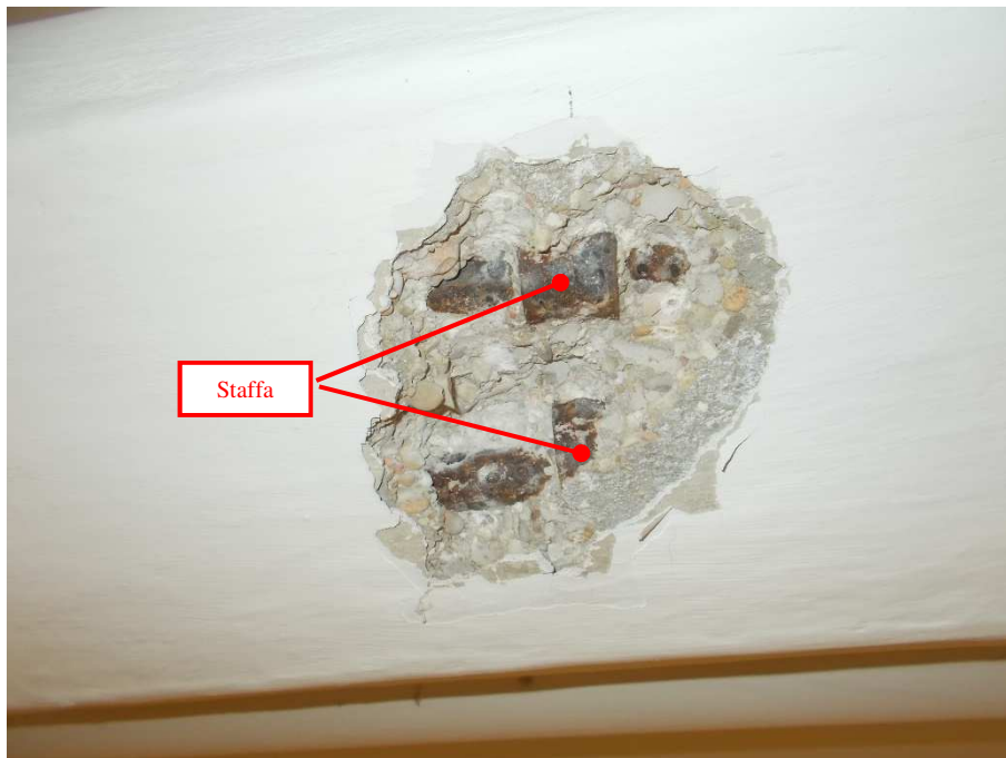
FOTO 13 – Piano Primo. Staffa costituita da un piatto di acciaio di spessore 2 mm e largo 26 mm
