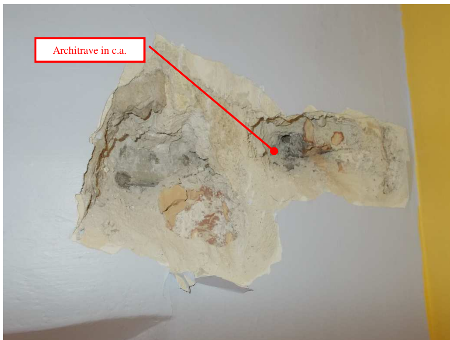
FOTO 11 – Piano Primo. Architrave in c.a. con tratto di appoggio di circa 15 cm.
