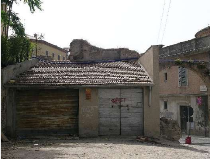
Figura 6: L'edificio da demolirsi nel progetto di riqualificazione della piazzetta
