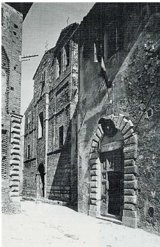
Figura 13: Una foto dei primi anni del '900 della piazzetta: in fondo è la facciata della chiesa di S. Anna, in primo piano un ingresso dell'Ospedale, a sinistra lo spigolo del Palazzo Mei Gentilucci (Pirani 1998, p.16)
