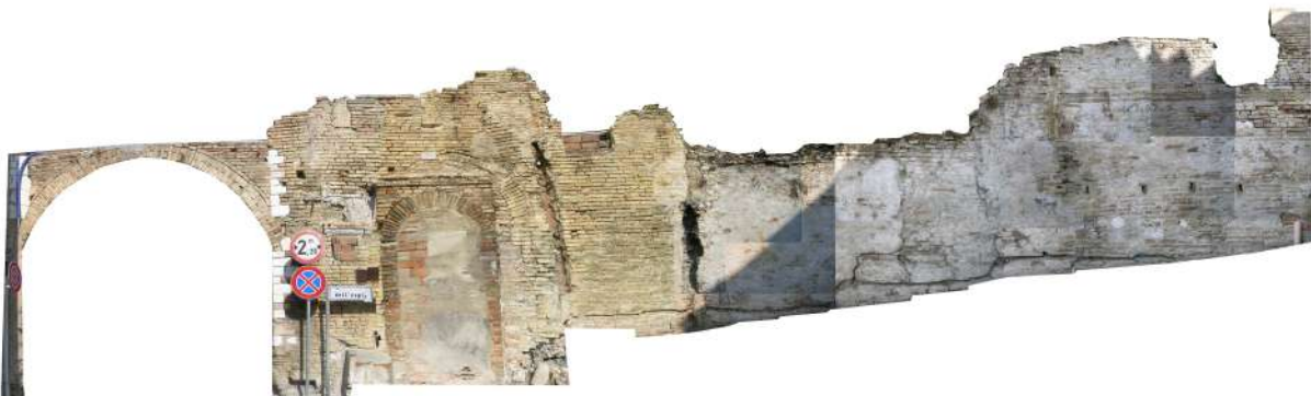
muro lungo la scalinata di via dell'Ospizio
