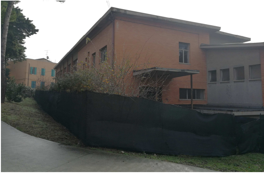
Ingresso Corpo D
