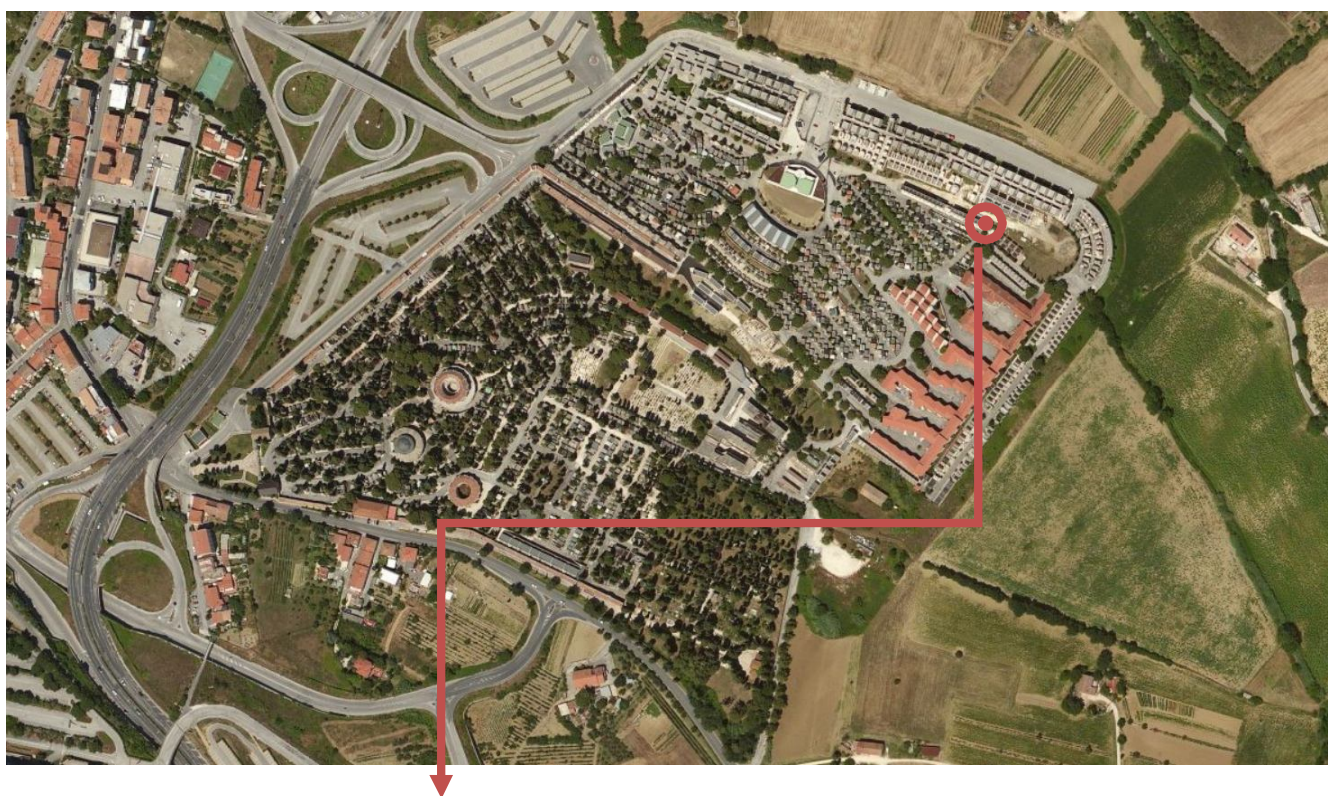
Lavori di realizzazione di colombari 49 b5 e b6
