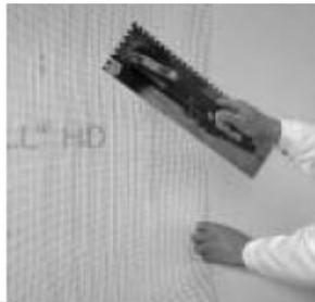
applicazione a pressione della malta sopra la rete di armatura posata
