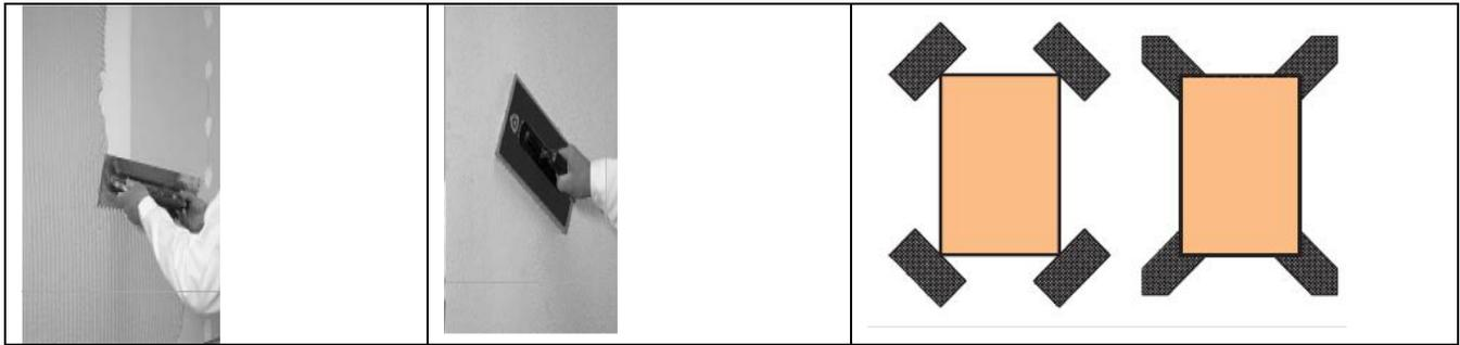
sovrapposizione 10 cm delle giunte della rete di armatura
