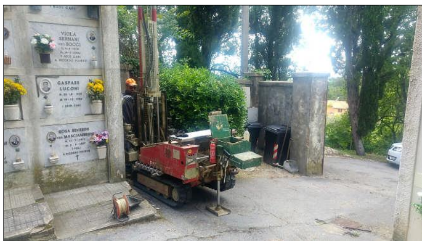
Prova penetrometrica statica Ps2 in fase di esecuzione.
