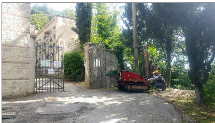
Prova penetrometrica statica Ps1 in fase di esecuzione.
