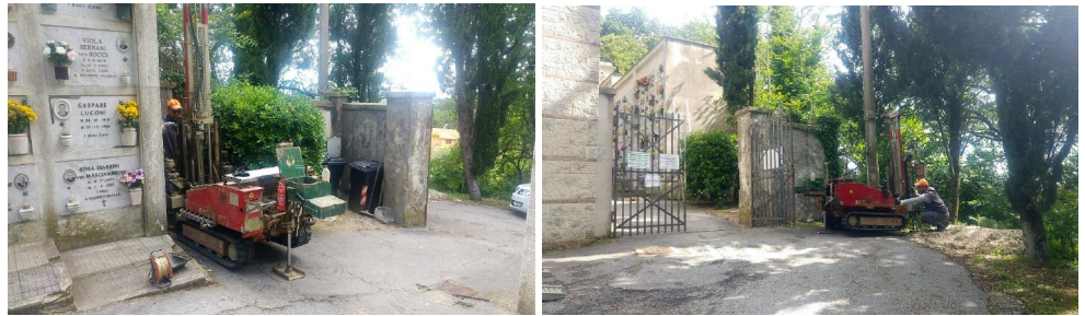
Fig.6 –Penetrometrie in fase di esecuzione
