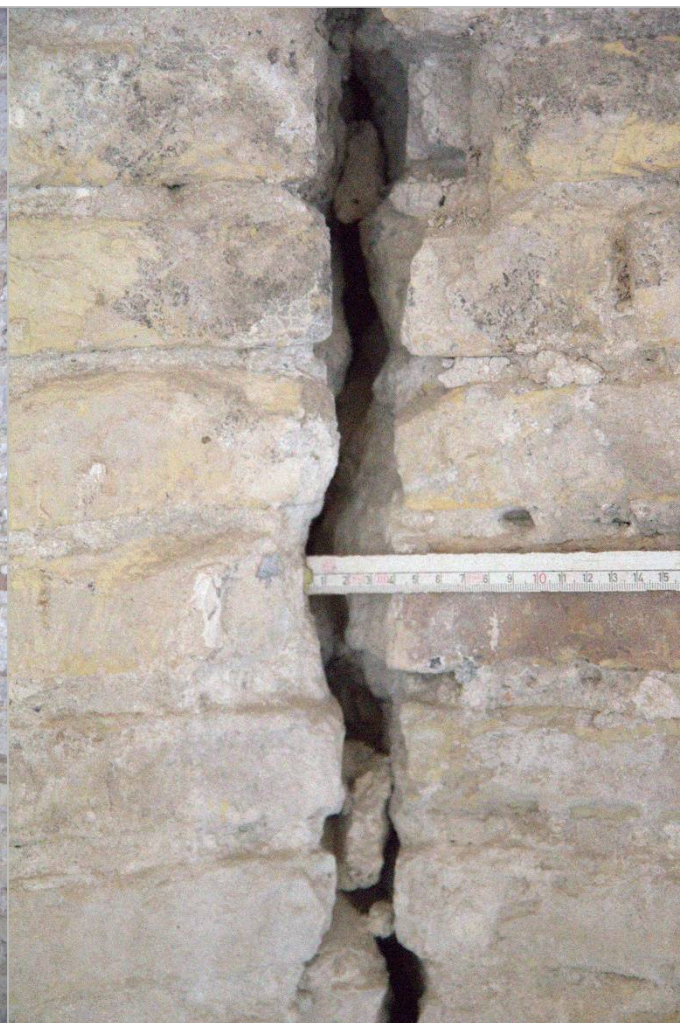
QF_40: quota 7,80 m Apertura della fessura verticale
