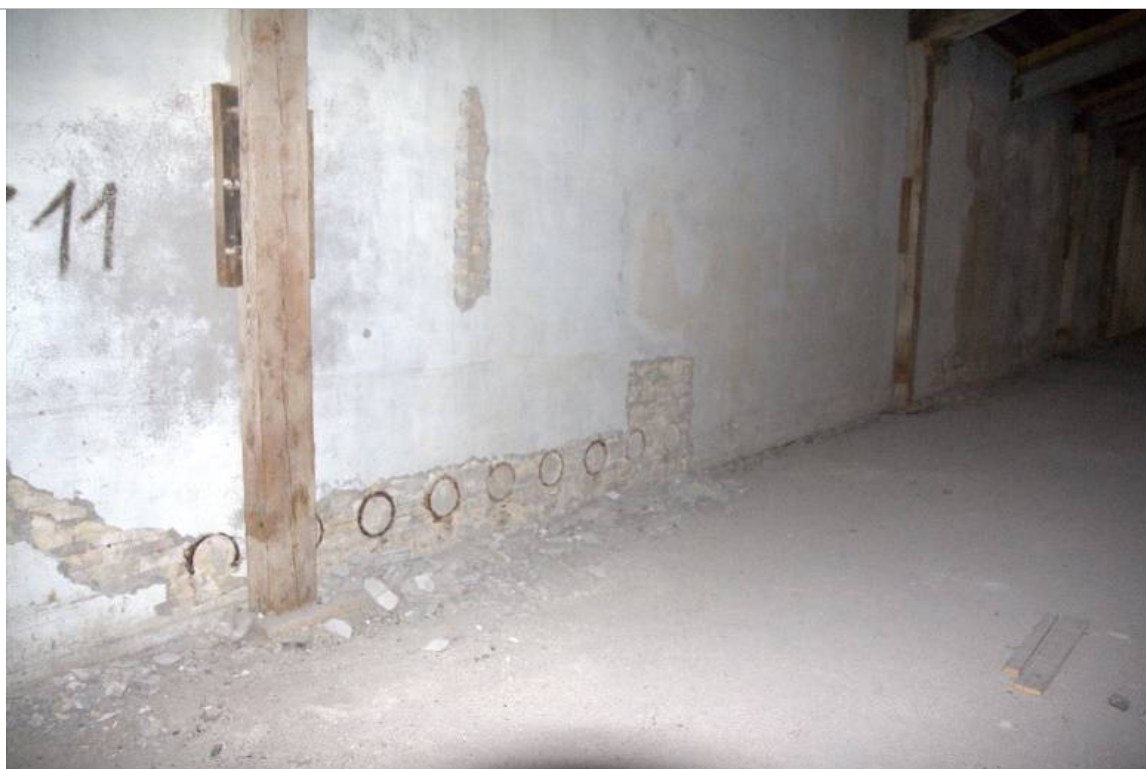
QF_87: quota 10,76 m Presenza di tubi in acciaio che attraversano la parete
