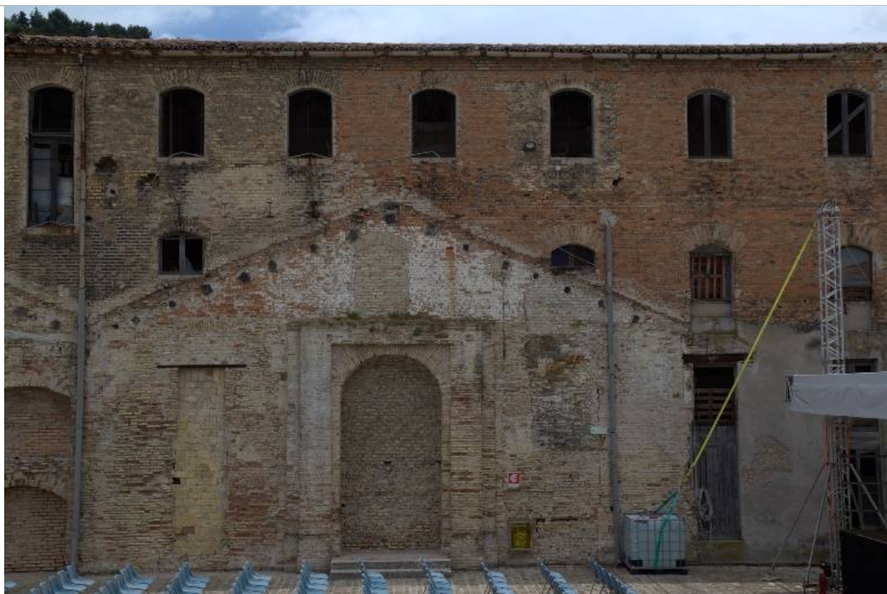
QF_103: facciata interna
