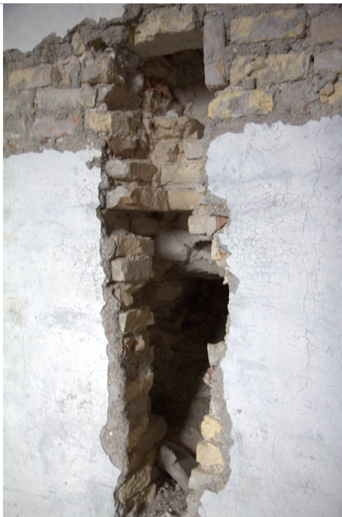
QF_90: quota 10,76 m Apertura su parete interna
