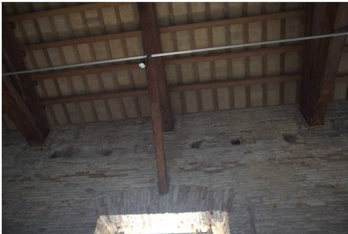
QF_70: quota 10,76 m Presenza di nicchie da rimozione travi
