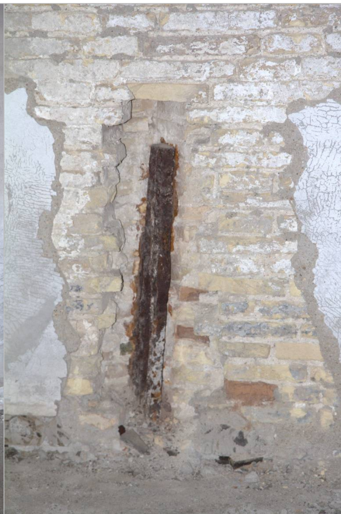
QF_58: quota 7,78 m Catene estradossate delle volte
