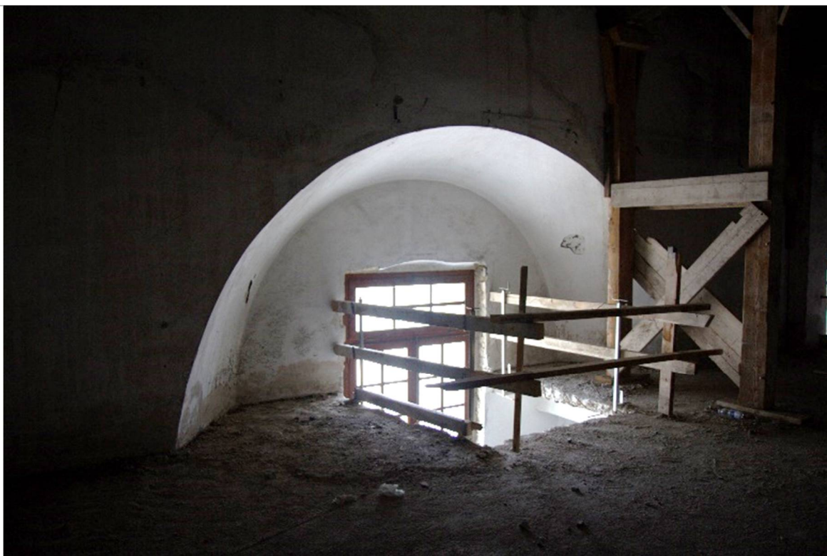
QF_86: quota 10,76 m Riduzione spessore della muratura
