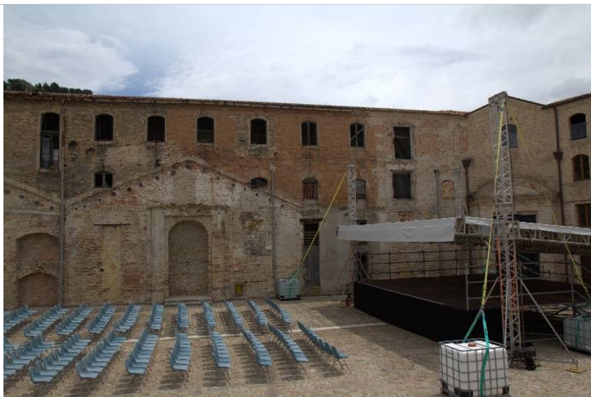
QF_101: facciata interna
