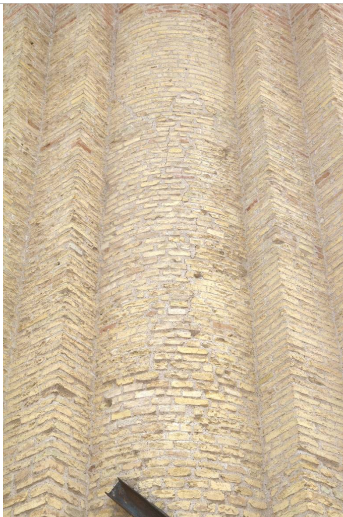
QF_3 :facciata esterna Fessure con espulsione muratura
