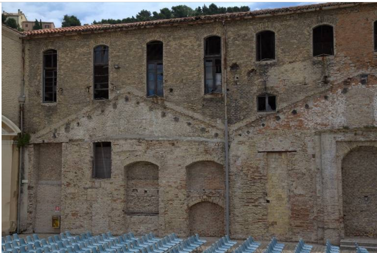
QF_102: facciata interna
