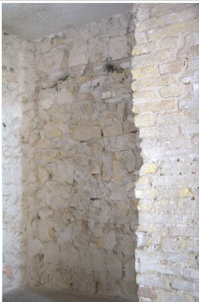
QF_36: quota 7,80 m Tessitura interna della muratura a vista su nicchia aperta
