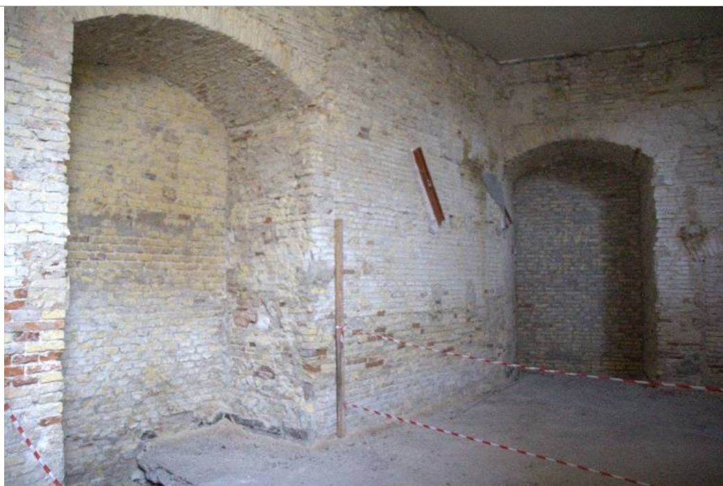
QF_30: quota 1,80 m Arcata parzialmente richiusa
