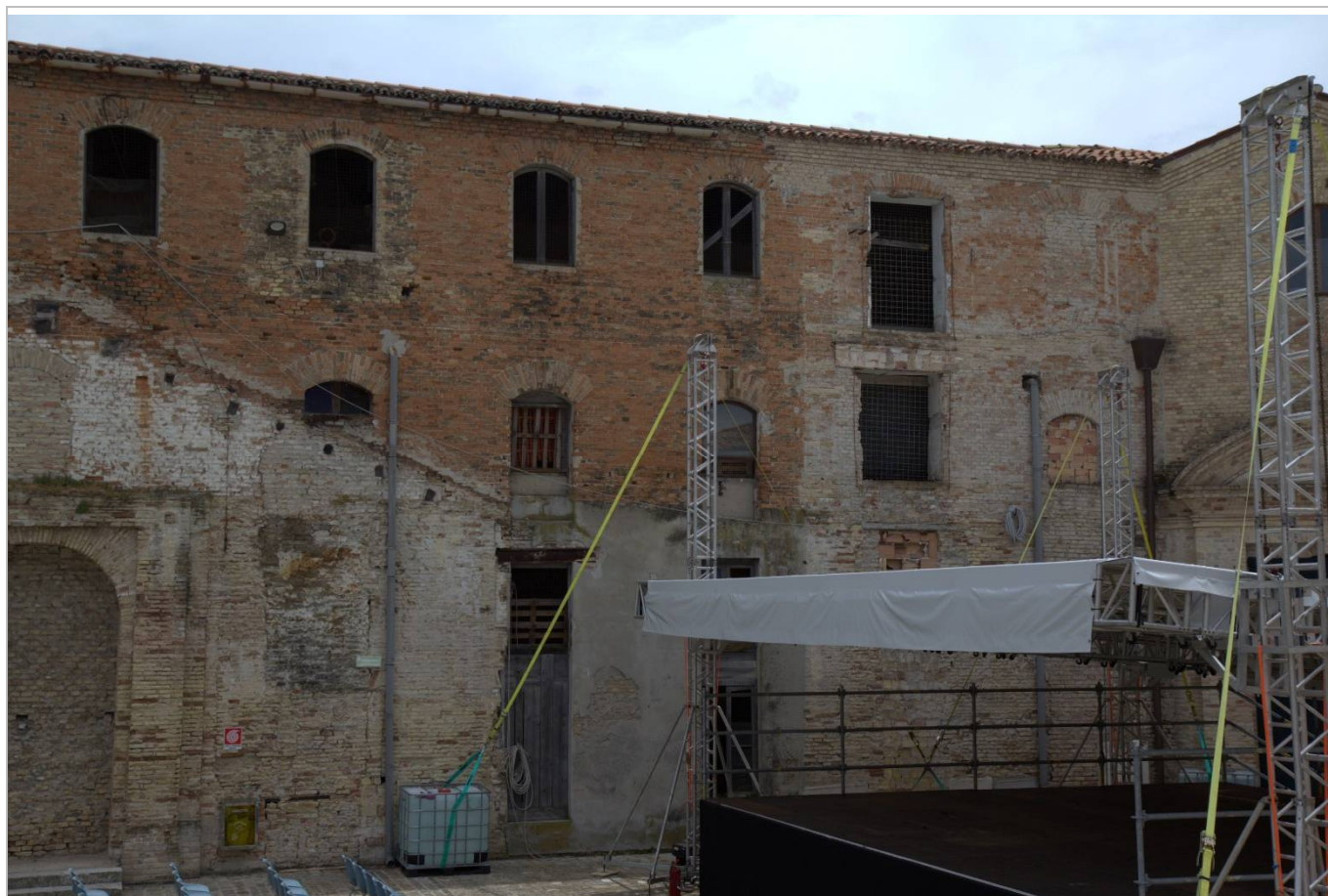
QF_104: facciata interna
