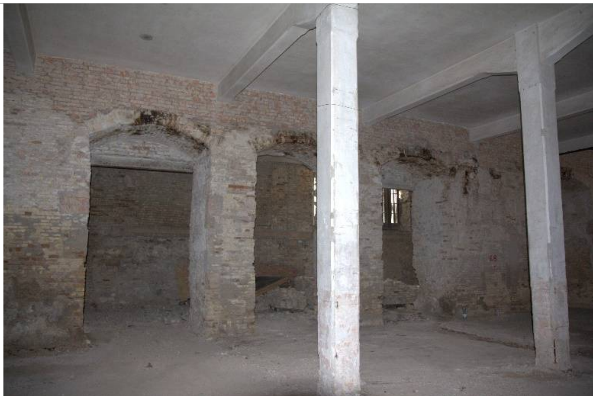
QF_19: quota 1,80 m Arcate completamente aperte
