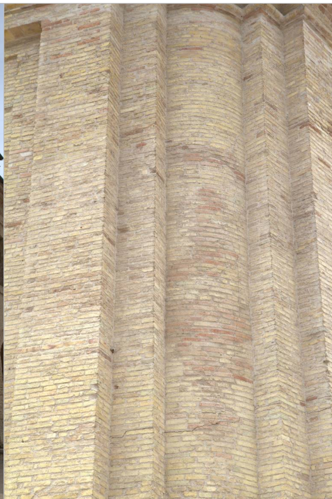
QF_10 :facciata esterna
