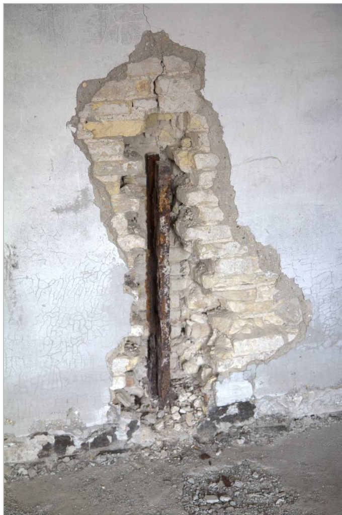
QF_57: quota 7,78 m Catene estradossate delle volte
