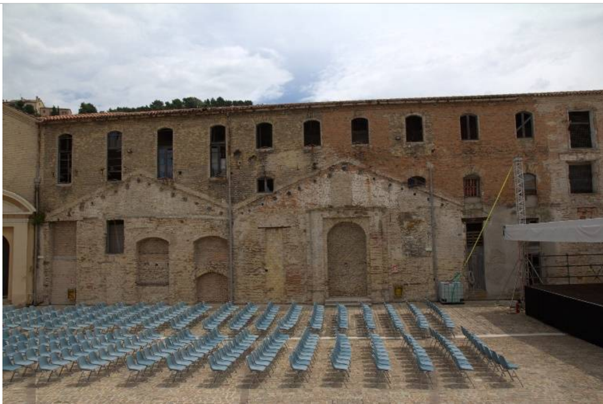
QF_100: facciata interna
