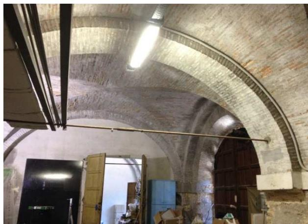
Figura 30 - Vista delle catene inserite nel 1971 alle reni delle volte del primo livello
