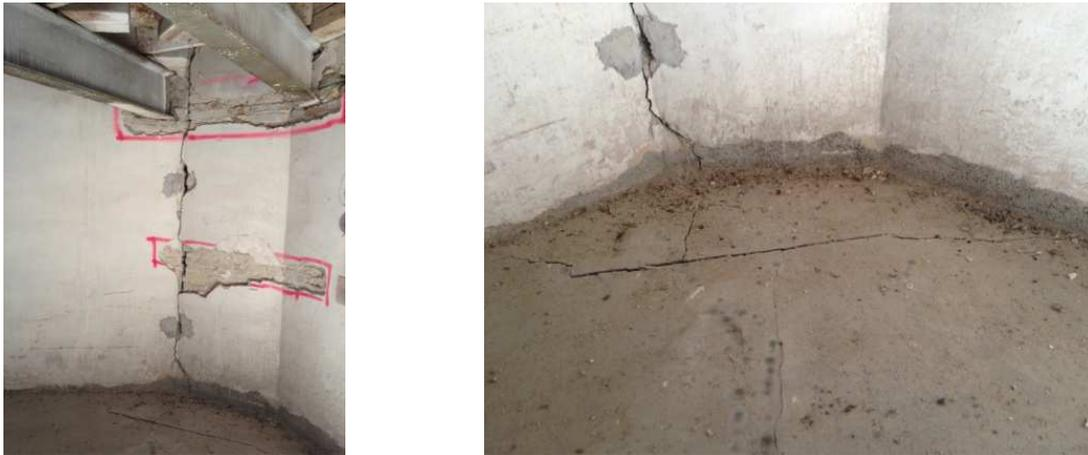
*Figura 55 - Lesioni in corrispondenza delle zone d'angolo a quota +7,80 m*
