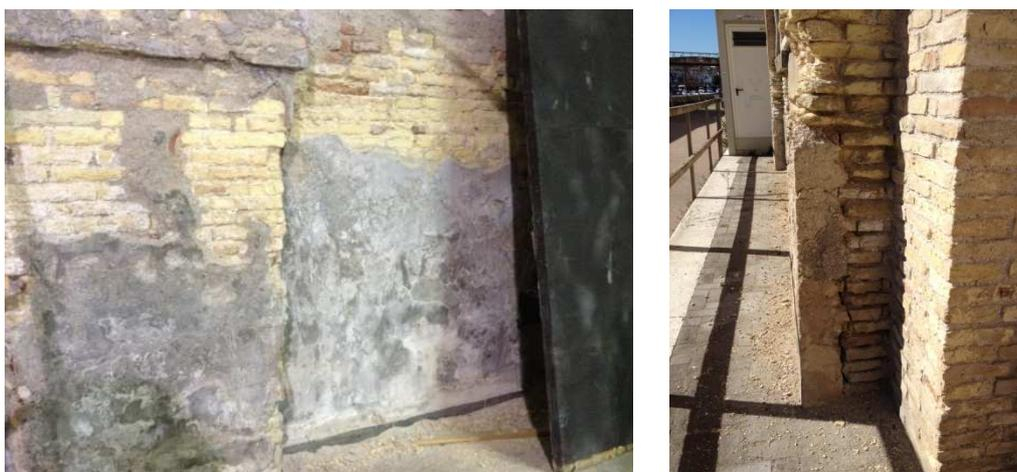
*Figura 57 - Diffuso degrado delle murature*
