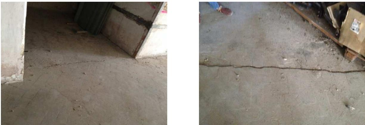
*Figura 56 - Lesioni all'interfaccia tra la soletta ed il solaio preesistente*
