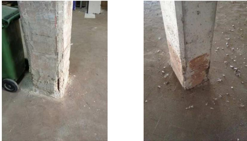
*Figura 58 - Segni di degrado alla base dei pilastri*
