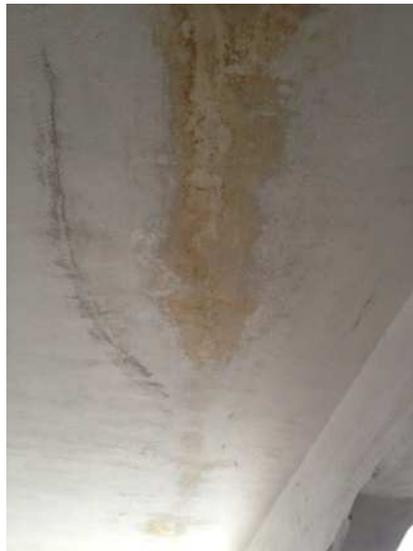
*Figura 59 - Segni delle infiltrazioni di acque meteoriche*
