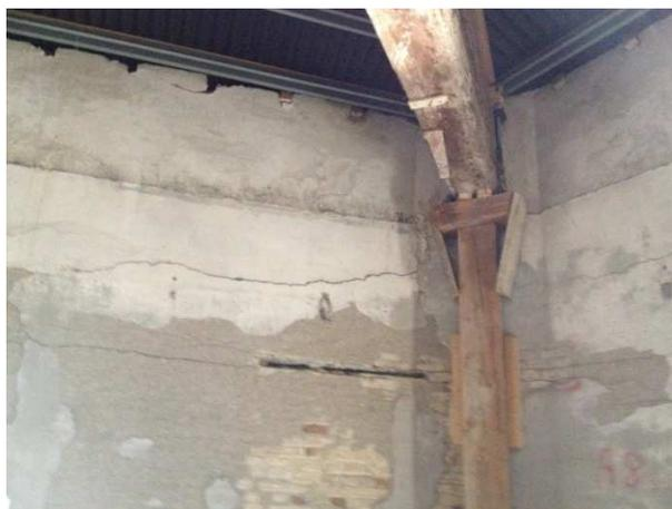
Figura 31 - Vista delle cuciture armate realizzate nelle zone d'angolo
