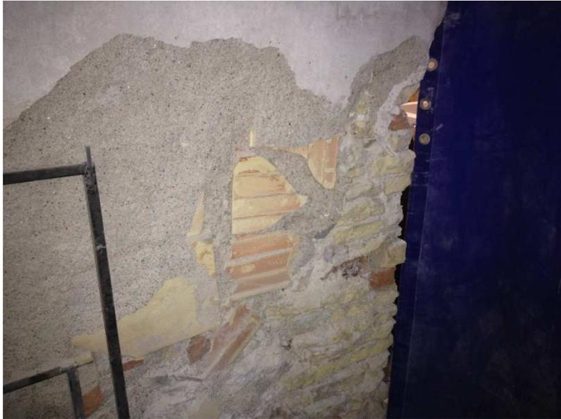
*Figura 39 - Stratigrafia della muratura che costituisce la Mole*
