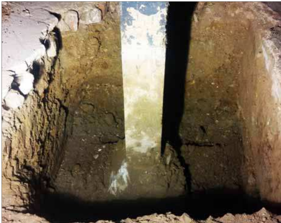
Figura 21:Trincea 3. Pilastro in cemento armato con relativo basamento relativo alla fase III
