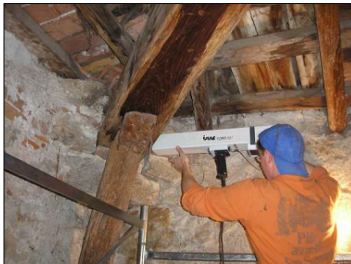
Figura 2.1 Ispezione strumentale – Prova resistografica all'appoggio di un falso pontone
