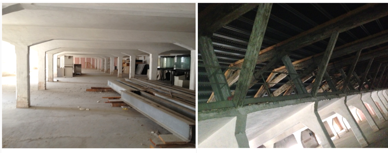
Figura 2.1 Viste interne della struttura "Nervi"
