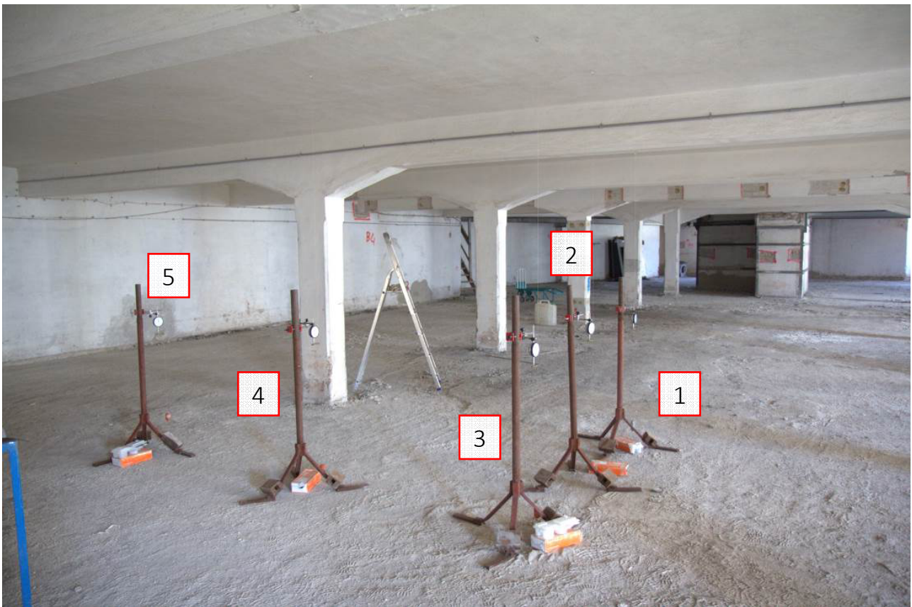
Foto 4.2 Posizione dei sensori di spostamento
