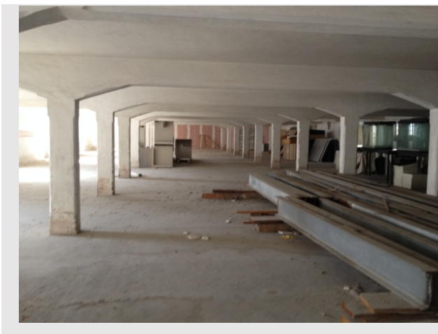
Figura 2-1 - Vista dei telai in c.a.(quota +7,80 m)
