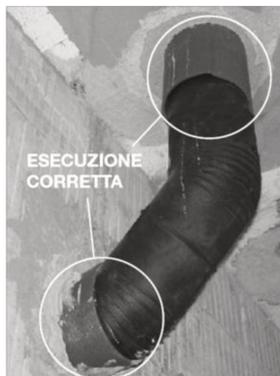
Figura 10.5 - A) disaccoppiamento realizzato con guaina isolante Geberit.
