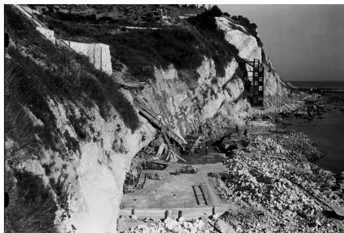
Anni '30. Lavori di costruzione della scalinata. La base della scalinata è stata gettata e un gruppo di operai sta provvedendo ai lavori. A destra, superato lo scalandrone, prima della sedia del Papa, si arrivava allo stabilimento balneare su palafitte; notare anche in questa foto la massiccia presenza di grotte "storiche".
