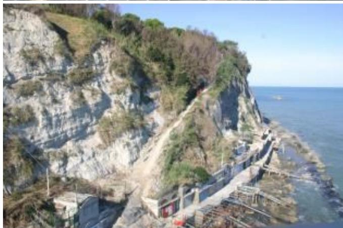
In generale l'inclinazione delle pareti oscilla intorno ai  $70^\circ$  ed i crolli di materiale lapideo dovuti alla intensa fatturazione legata anche ai fenomeni sismici hanno determinato una sezione-tipo in cui la parte superiore (ad una quota che da 40 arriva a superare i 100 ml s.l.m.) ha andamento sub-verticale corrispondente al materiale più rigido mentre la parte inferiore ha inclinazione minore per il formarsi di conoidi in cui si accumulano i detriti a granulometria più minuta.
