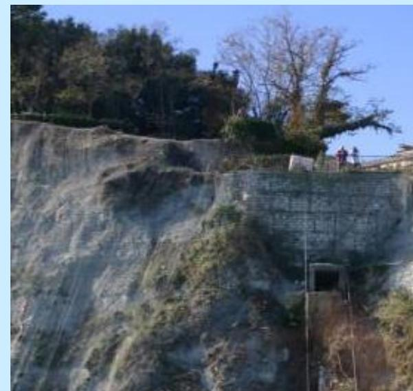
Esempio di messa in sicurezza tramite l' impiego di reti metalliche nella parte di falesia più a sud.
