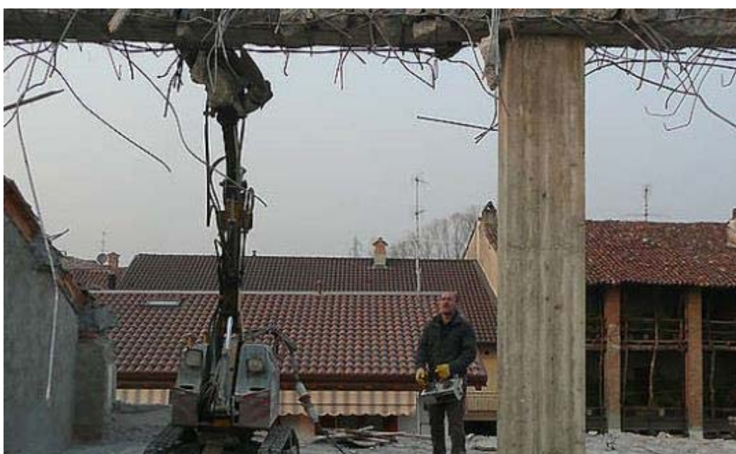
Figura 4. Immagine di demolizione/frantumazione di strutture in cemento armato per mezzo di macchine radiocomandate Brokk e/o manuali nel pieno rispetto dell'incolumità degli operatori addetti ai lavori.
