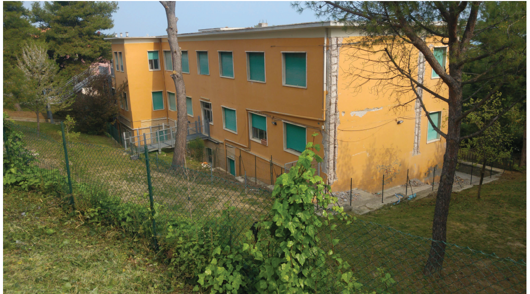
Figura 2: Edificio esistente da demolire
