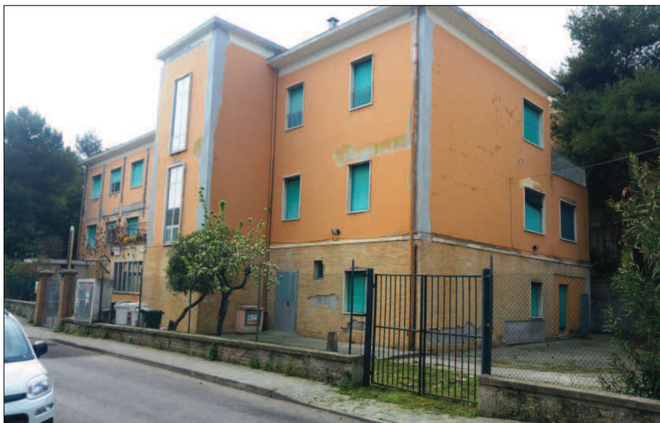
Foto 1 : Particolare della scuola Mercantini da demolire e ricostruire ripresa da via Mercantini.
