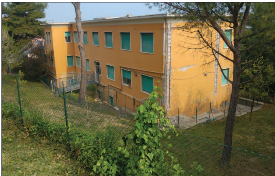
Foto 2 : Particolare della scuola Mercantini ripresa da via Redi
