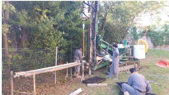
Fig. 8: Sondaggio a carotaggio continuo in fase di esecuzione
