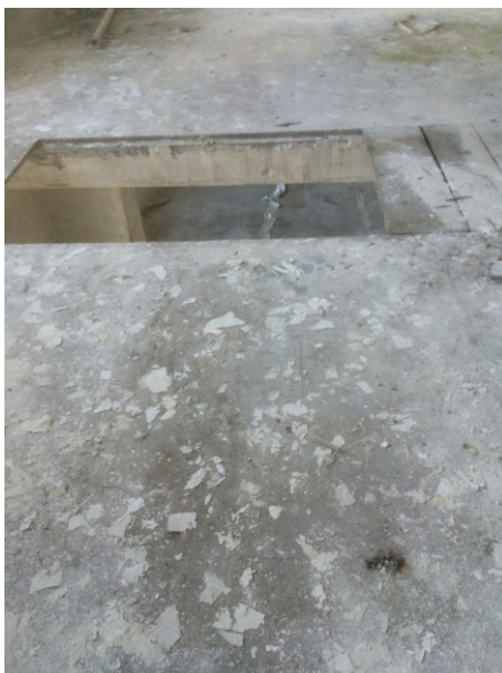
APERTURA SU SOLAIO
