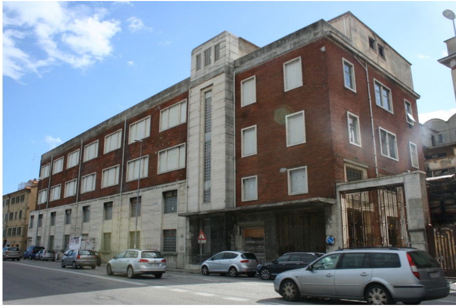
FACCIATA PRINCIPALE ED INGRESSO (EDIFICIO "A")
