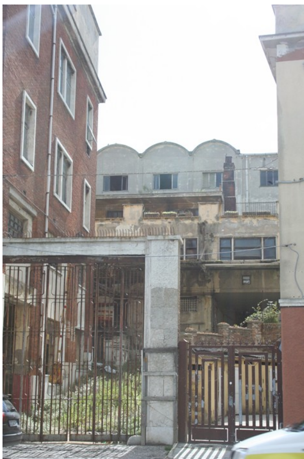
CANCELLO DI ACCESSO ALL'AREA
