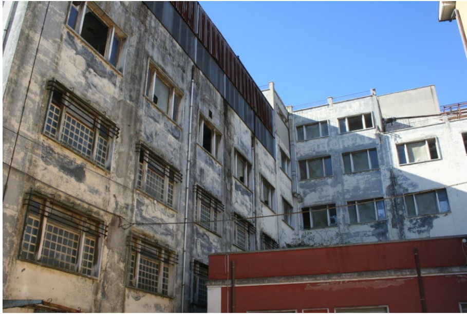
FACCIADE EDIFICIO (EDIFICIO "A")
