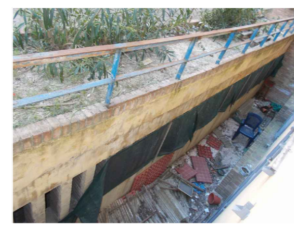
Foto 6: vista delle superfici di aerazione dell'autorimessa dal piazzale esterno
