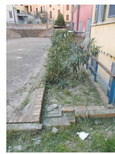
Foto 4: vista del terrapieno vegetale da asportare in sede di progetto
