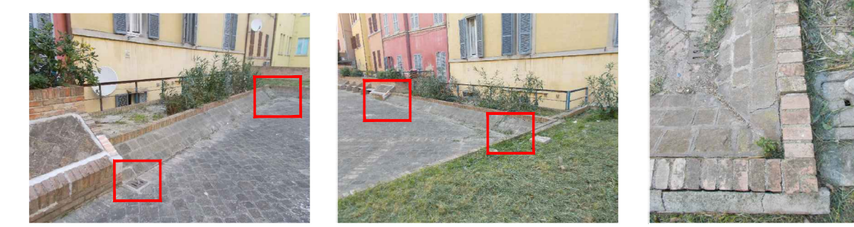
Foto 2 e 3: vista laterale della pavimentazione in pendenza fino ai pozzetti di scolo
