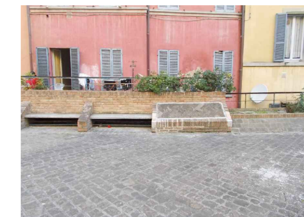
Foto 1: vista frontale delle velette in muratura piena a sostenere le panche in lastroni presenti
