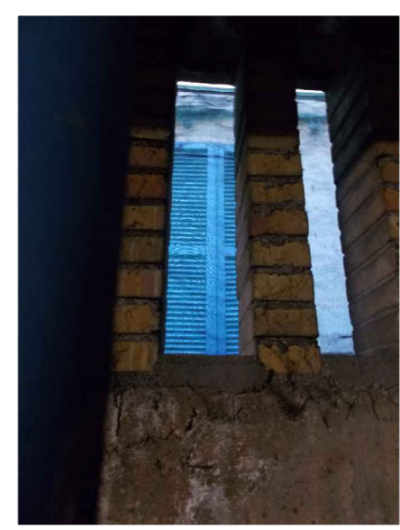
Foto 8: vista delle superfici di aerazione dell'autorimessa da
