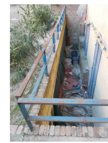
Foto 5: vista della balaustra da trattare con antiruggine e da riutilizzare in sede di progetto in quanto in ottimo stato di efficienza
