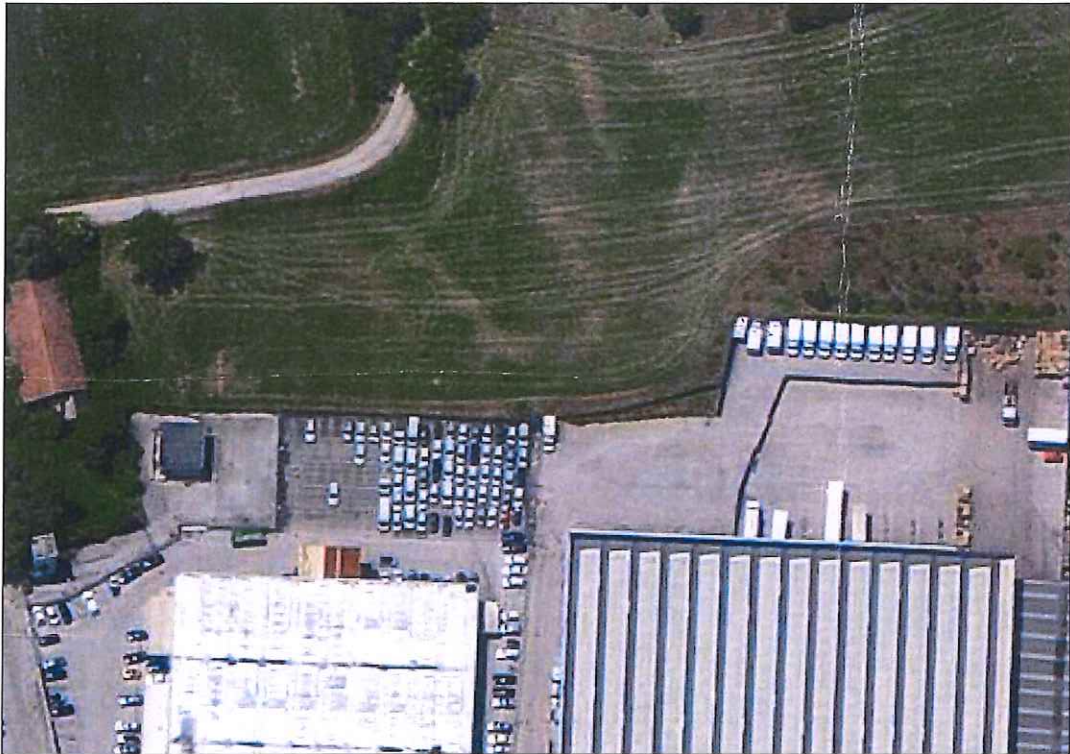
Stato attuale area oggetto di variante urbanistica
