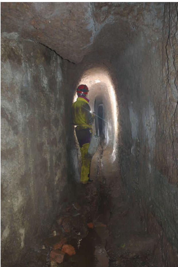
Figura 1 – Galleria dell'acquedotto in località Marcigliana (Palestrina, Roma; foto: C. Germani)
