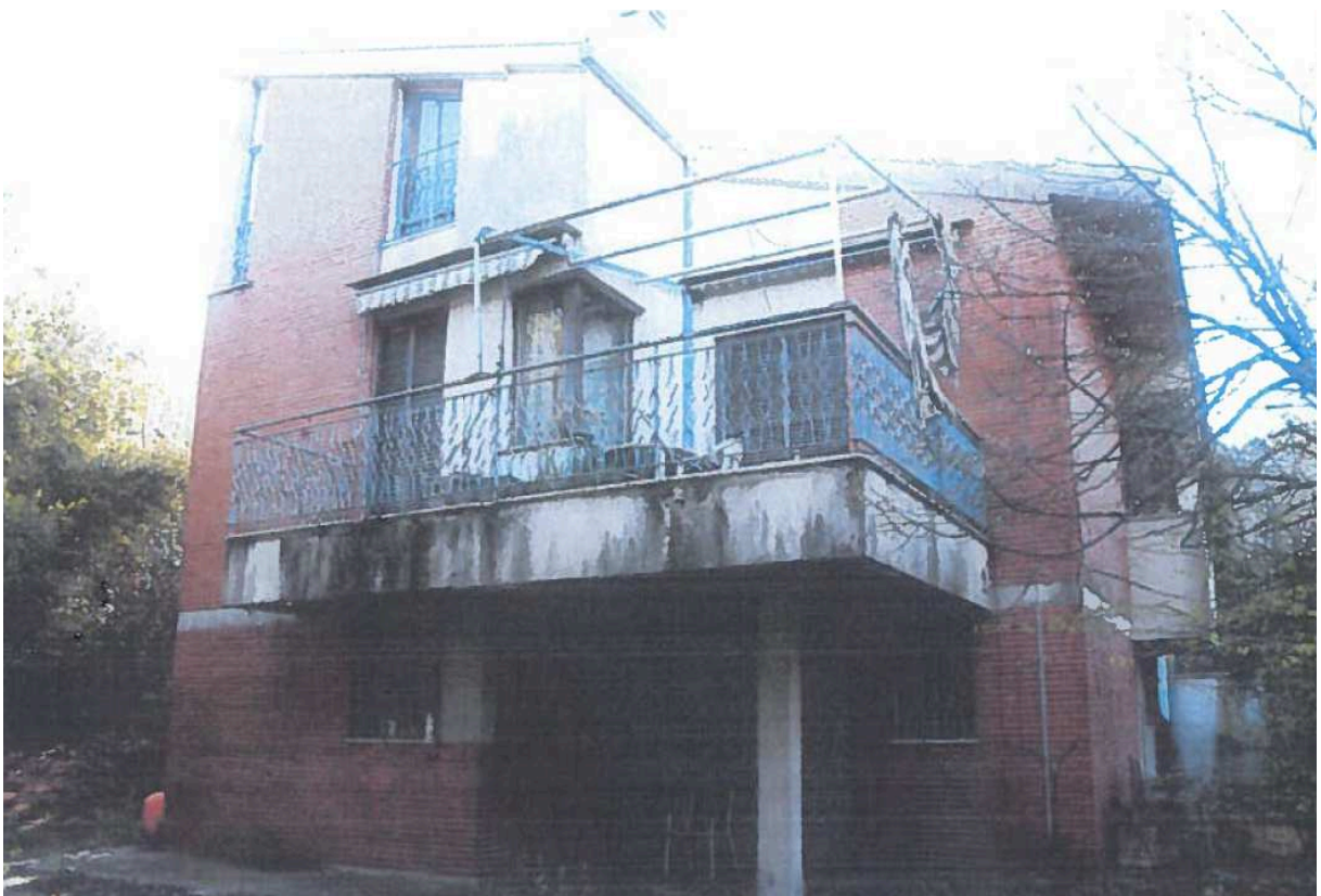
FIG. 3: PROSPETTO A VALLE DELL'EDIFICIO
