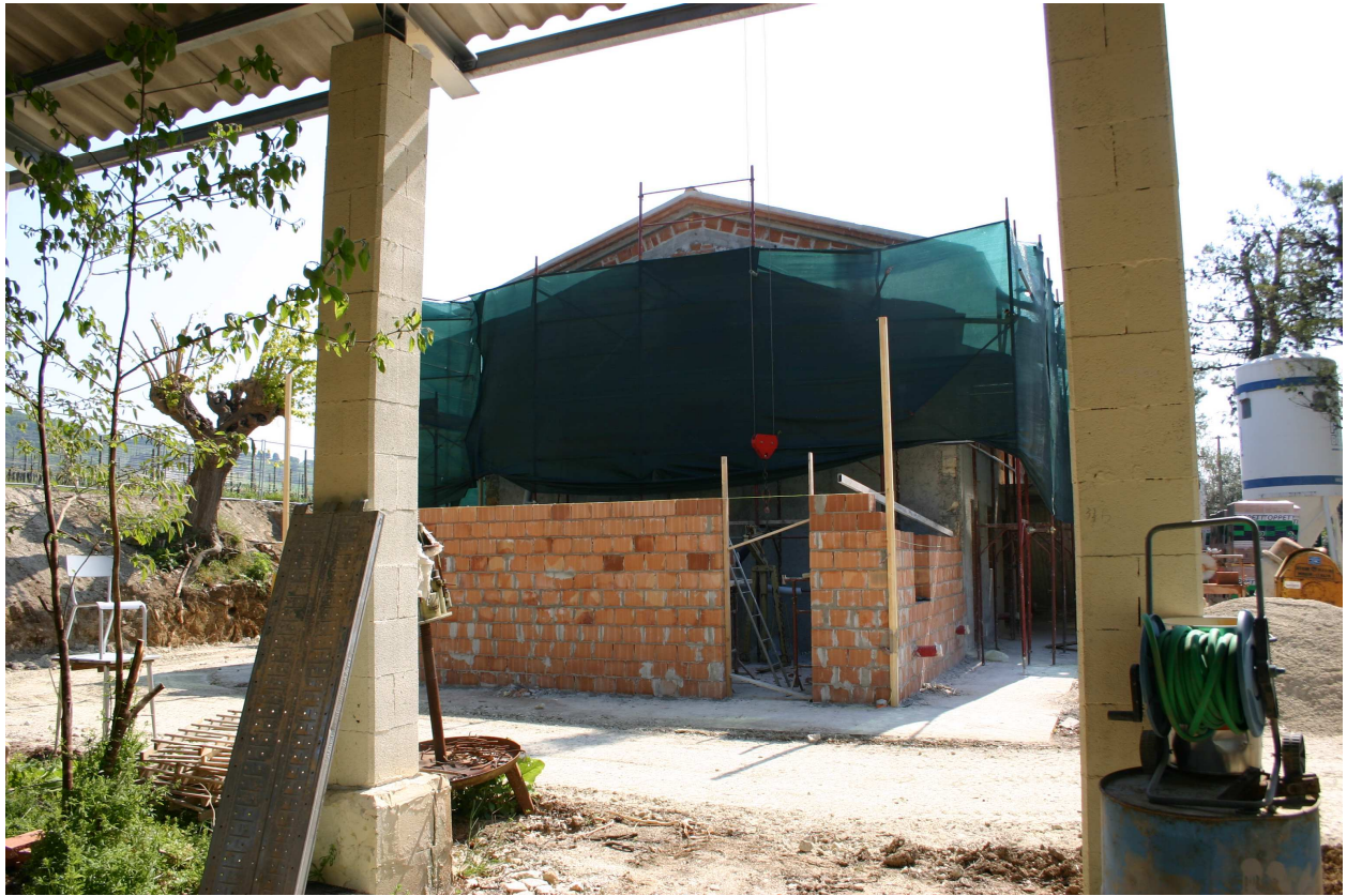
Immagine 4 – Foto dello stato attuale del complesso edilizio(edificio A).
