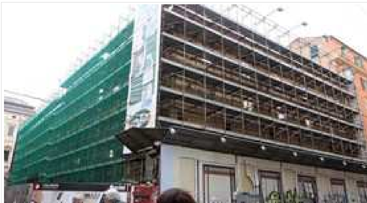
Vista dell'edificio in fase di ristrutturazione
