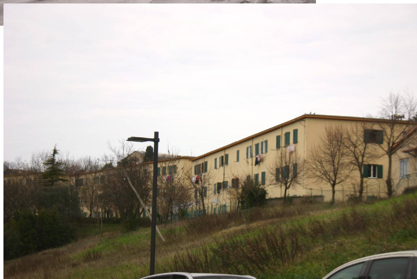
FIG. 3: VISTE DEGLI STABILI INTERESSATI
